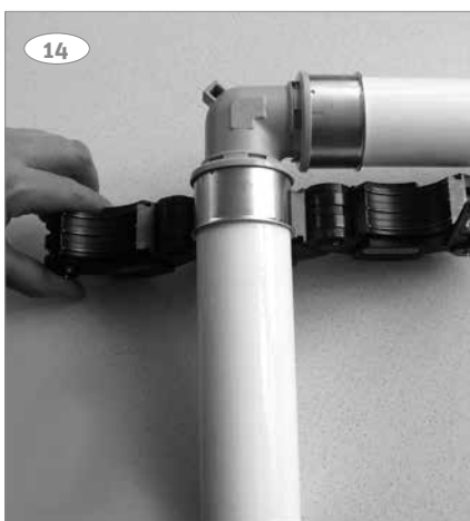
14: Placera pressringen på PressCheck®-kopplingen.
