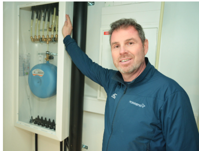
Lars Ketil Aune, Roths distriktschef i Midt-Norge visar fördelarskåp som är monterade i alla hus/lägenheter på Jessheim.
